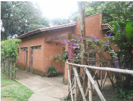
Figura 11: Instalações do para-raios sem haste e captor Franklin.
