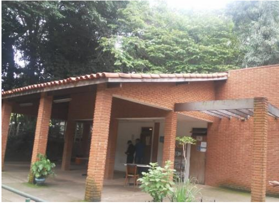
Figura 10: Instalações do para-raios sem haste e captor Franklin
