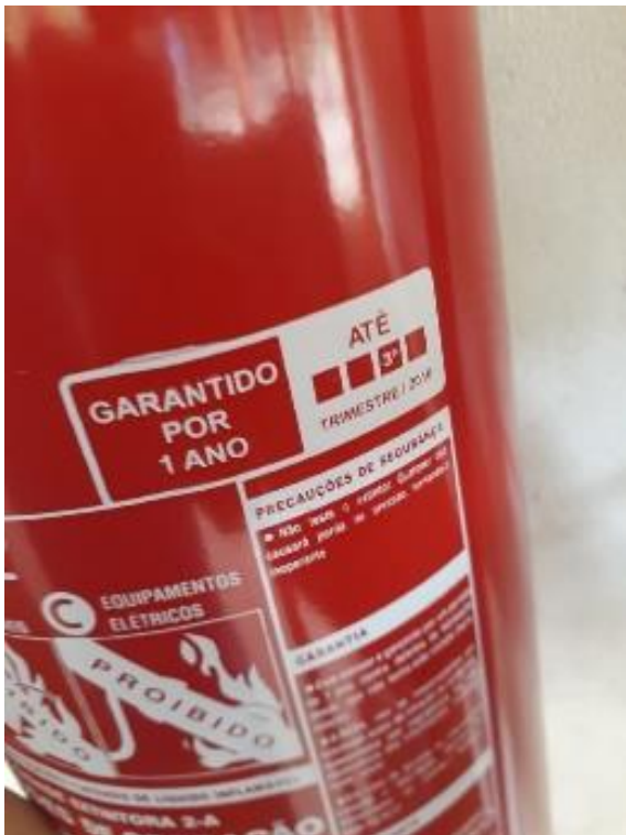
Figura 4: Extintores de vencido.
